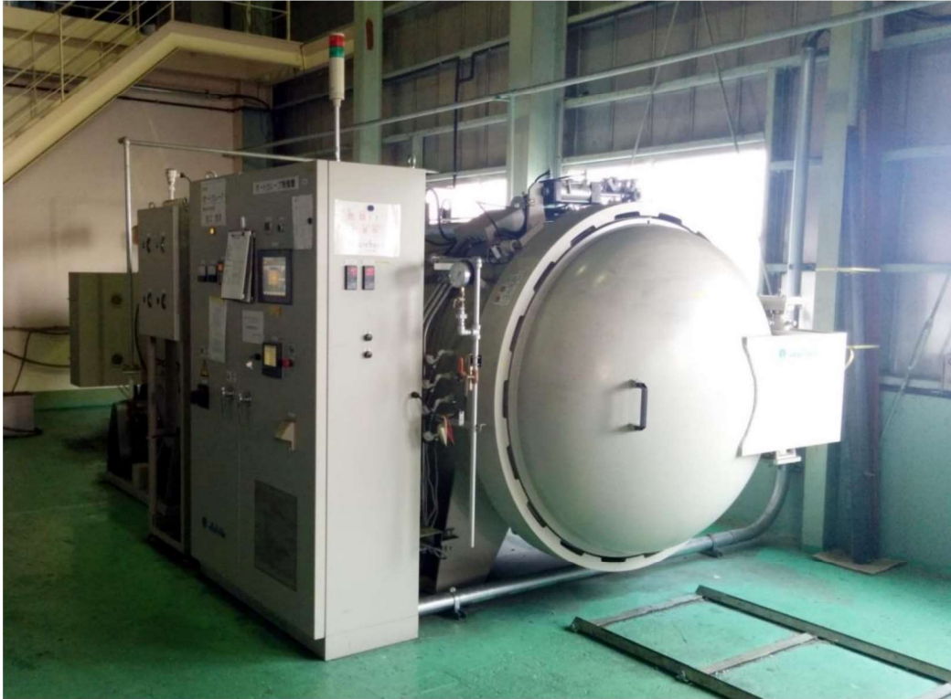
第二工場オートクレーブ
