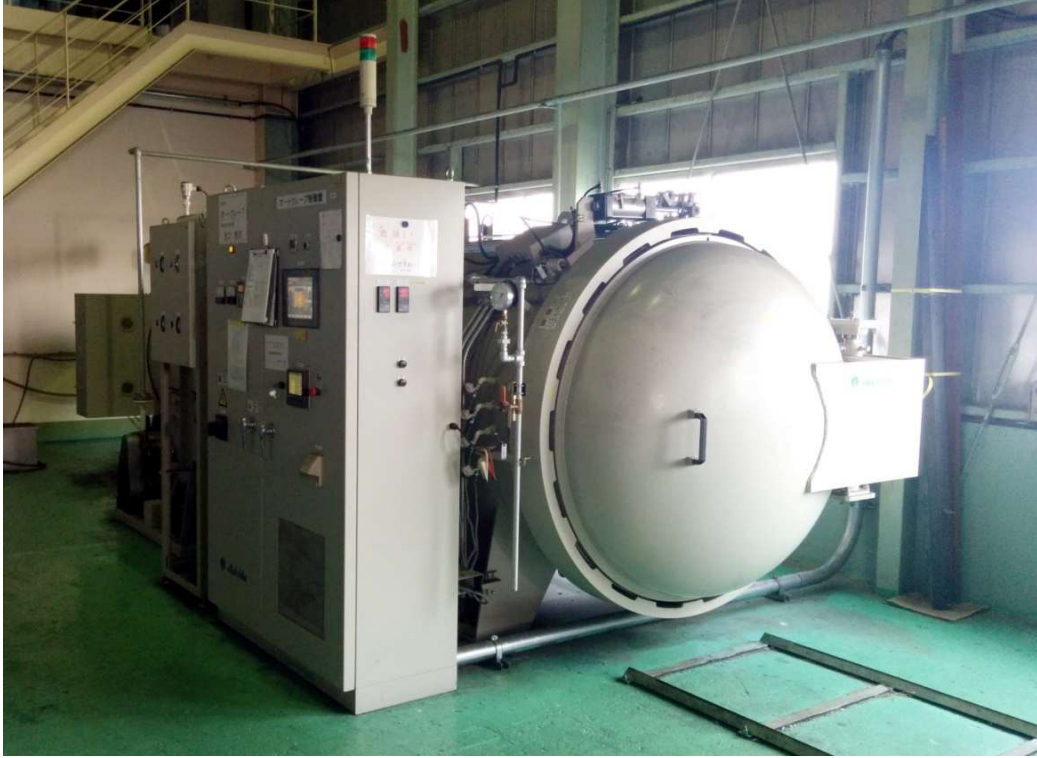
第二工場オートクレーブ
